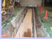
型枠が出来ました
