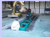
隙間はコンクリートで固めます
