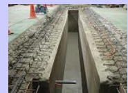
型枠取ったら基礎が完成
