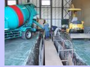
生コン、ラブ注入~!
