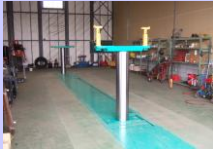
2柱リフト完成しました
